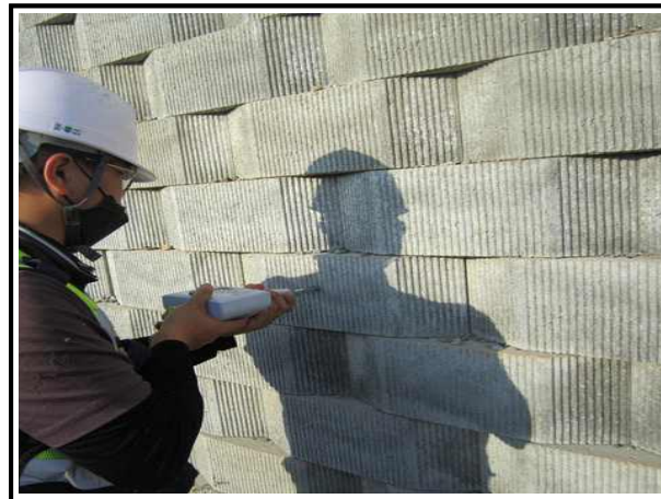
【그림 8.3.7】 슈미트해머를 이용한 반발경도시험 전경
